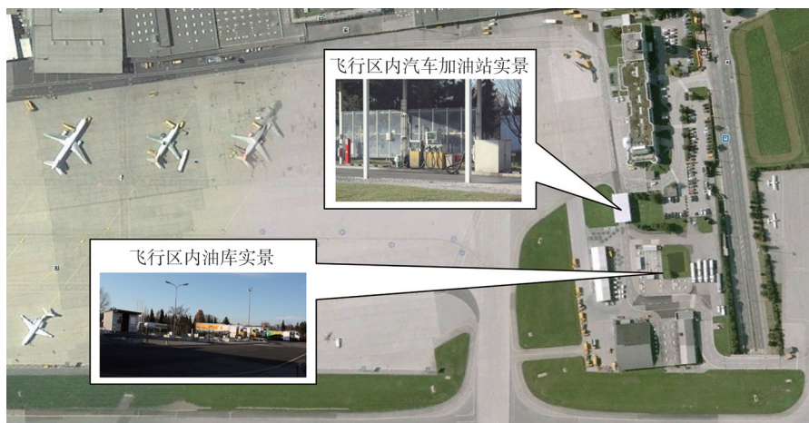
图 4.1.4 某机场飞行区的油库及汽车加油站
