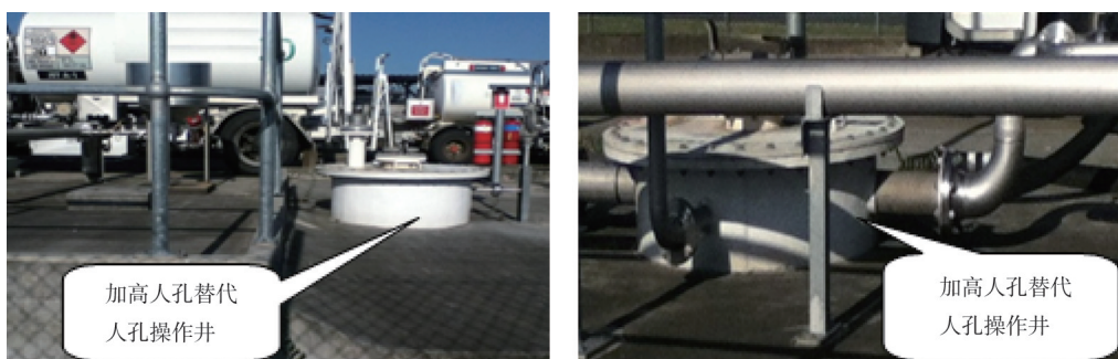
图 6.4.5 加高人孔替代人孔操作井
