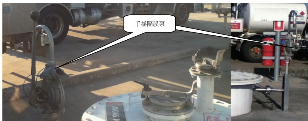
图 6.1.4-1 某机场排沉淀用的手摇隔膜泵
