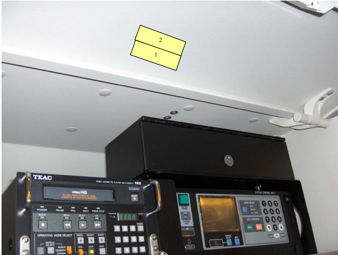
图 20: 存放录像设备的顶部行李箱一内部
