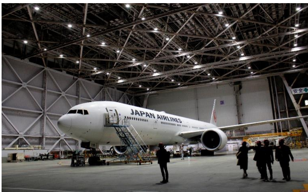
图 A6. 2. 2-3 日航第 2 维修机库
