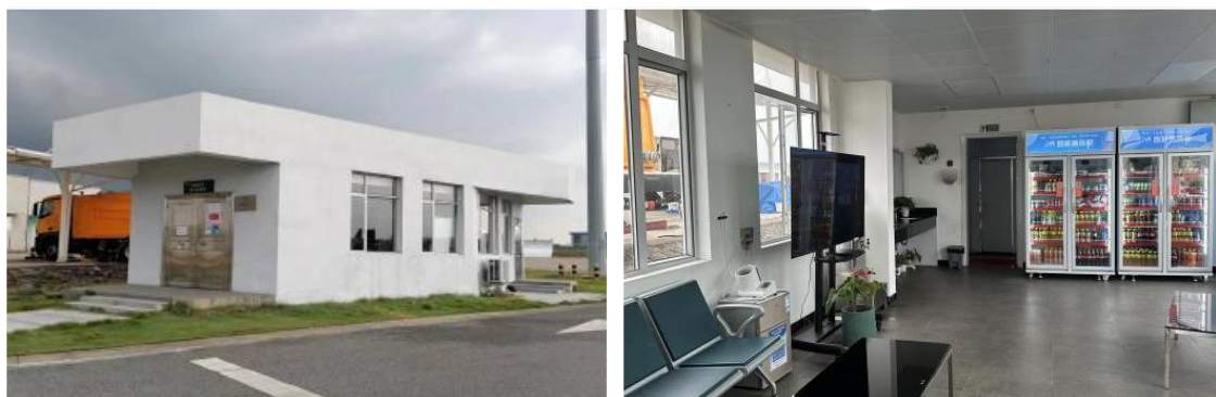
图 A.1.3-3 广州白云国际机场西南站坪职工休息区外观及室内
