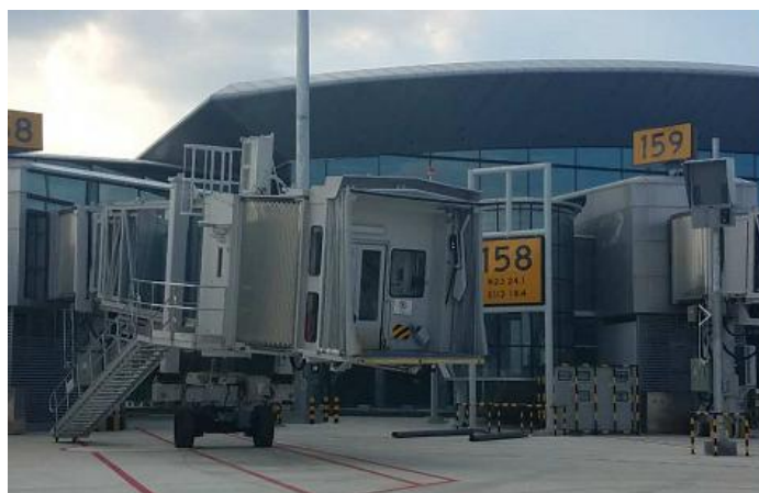
图 11.2-2 某机场 158 号机位标记牌被遮挡示意图
