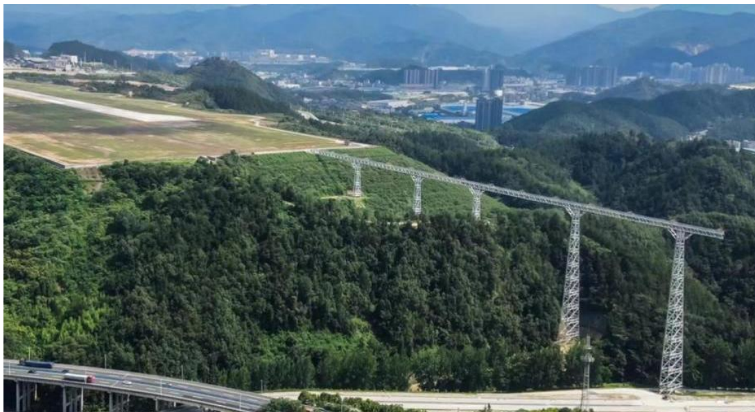
图 15.1 进近灯光桥梁建设案例
