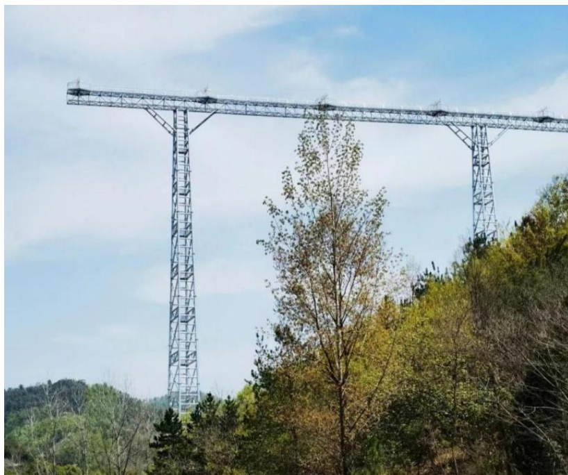
图 15.5 灯光桥边跨悬臂的长度需考虑其稳定性和疲劳效应
