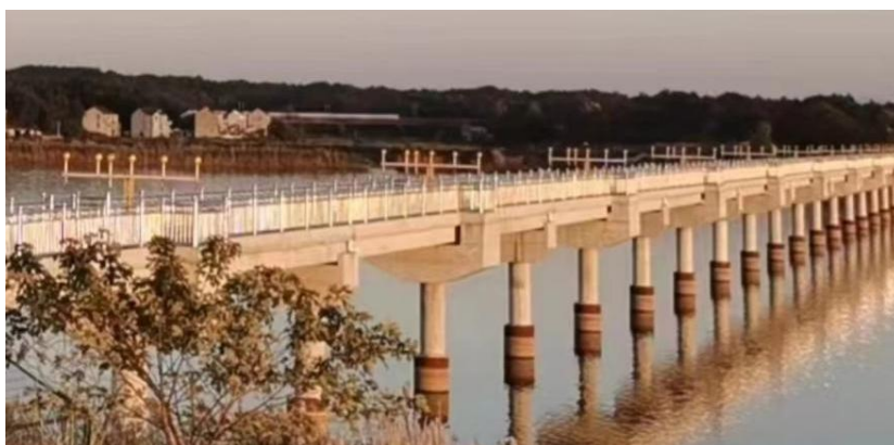
图 15.4-2 桥跨过小导致下部结构过多的方案
